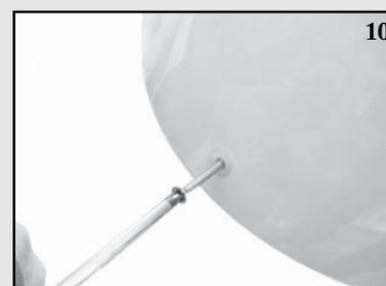
**IT** Utilizzando l'apposita vite e coprivite, fissare l'orinatoio nel punto D.
