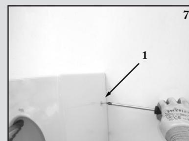
**IT** Utilizzando le apposite viti e coprivite (elementi 1), fissare l'orinatoio nel punto D.
